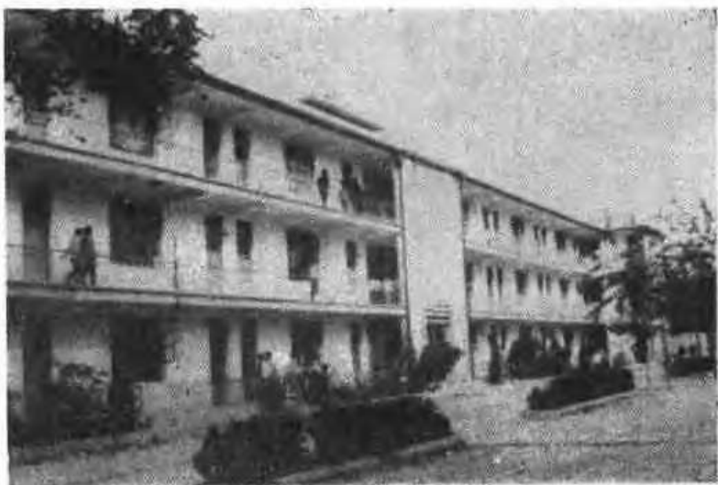
临清一中教学大楼（袁陶光、殷黎明、靳国君摄）
